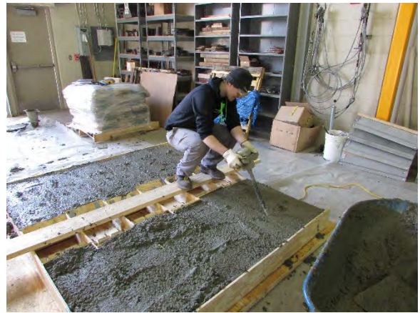
b. Pouring Concrete
