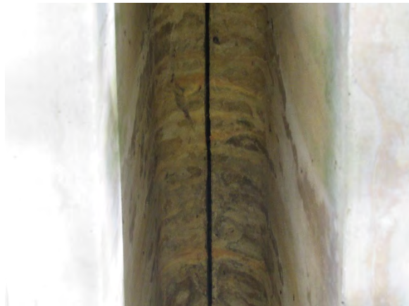
(d) Leakage from joint
