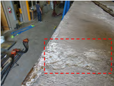
(d) Flange Cover Deterioration (CS-2)
