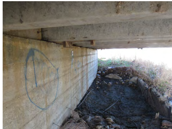
(d) Scouring at abutment of bridge
