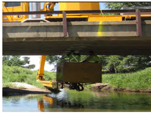
(d) Field Work Using Snooper Truck
