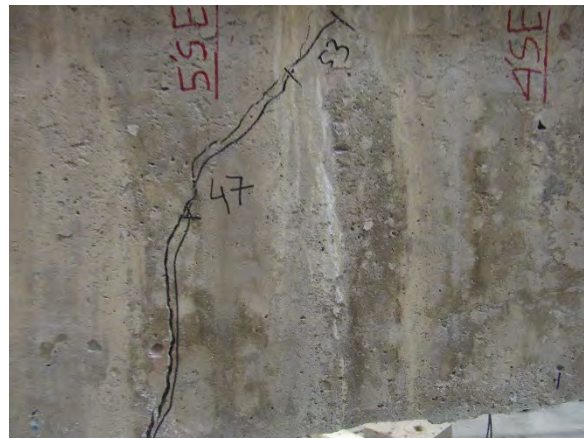
(d) Extension of Crack Width
