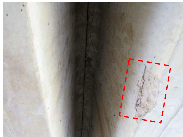
(d) Deterioration at bottom of stem
