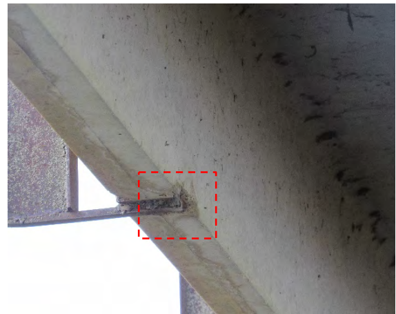
(d) Concrete Spalling at Railing
