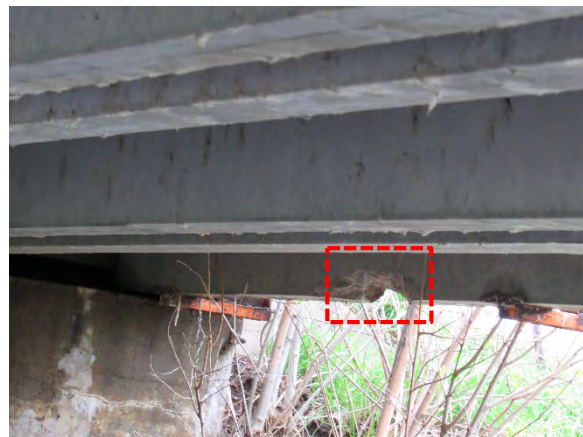
(d) Deterioration at bottom of stem
