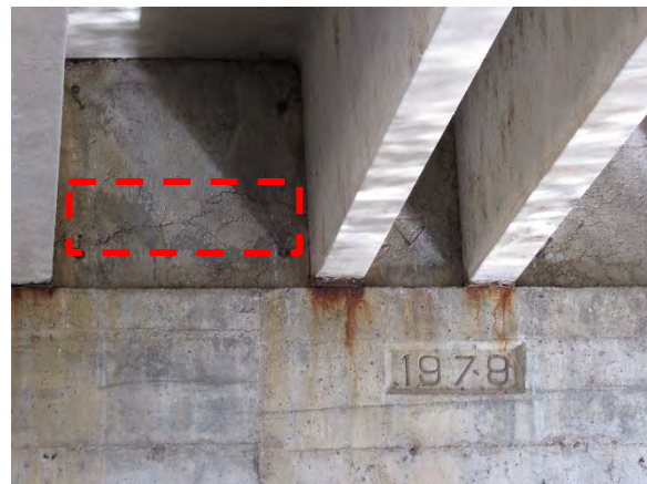
(d) Cracking in diaphragm
