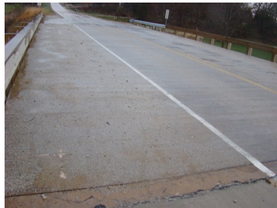
(d) Epoxy with Embedded Grit
