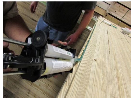
(d) Placing Epoxy in Deck-to-Deck Connection
