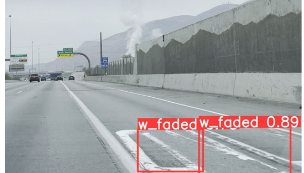
(d) Faded White Word Marking-2
